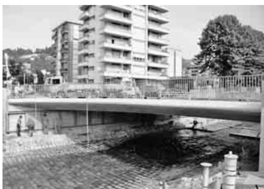
Il ponte nella sua versione "normale" e "sollevata" (in caso di piene eccezionali).
